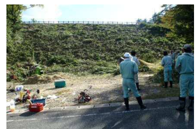
伐採後の堤体の様子
