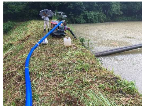
ポンプ設置状況
